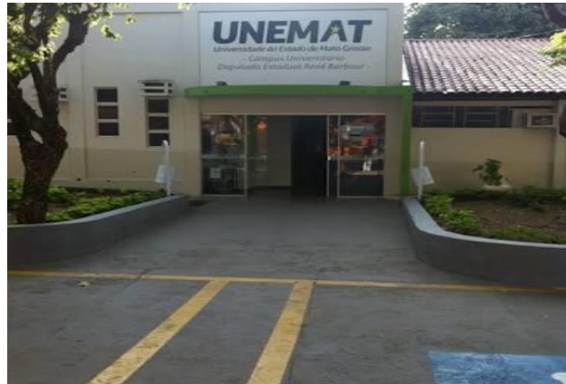
Figura 1 - Fachada do câmpus universitário “Deputado Renê Barbour” da UNEMAT no município de Barra do Bugres
