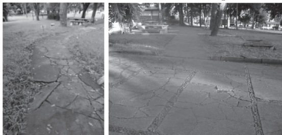
Figuras 8 e 9: Acesso do bloco de salas de aula do CTU para o calçadão central
