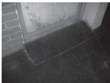
Figura 12: Rampa de acesso à sala de aula
