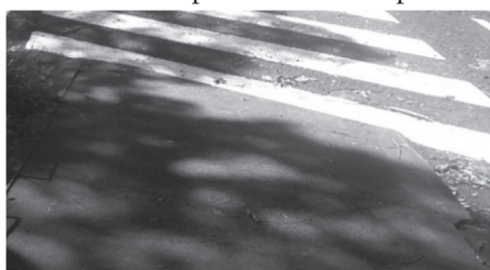
Figura 5: Acesso do estacionamento por meio de rampa
