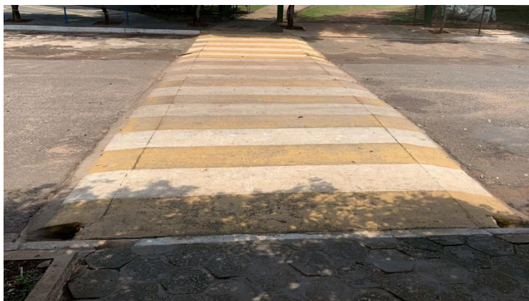
Faixa elevada para passagem, ligando os Blocos B e C, Campus de Barra do Bugres
