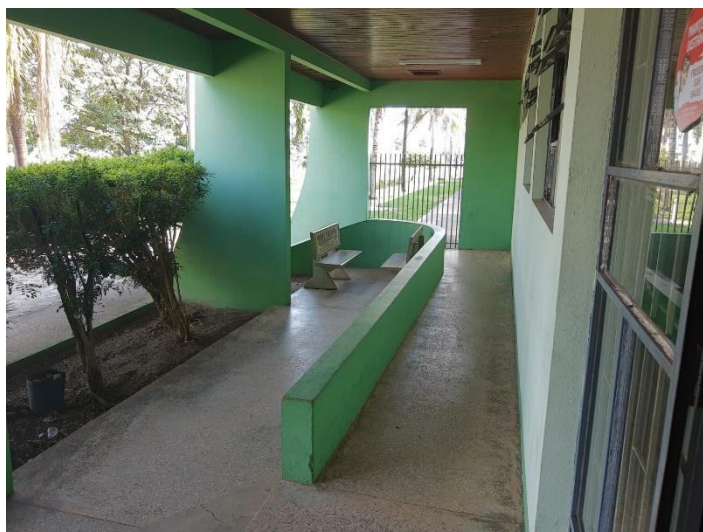
Rampa acessível Bloco A (entrada), Campus de Sinop
