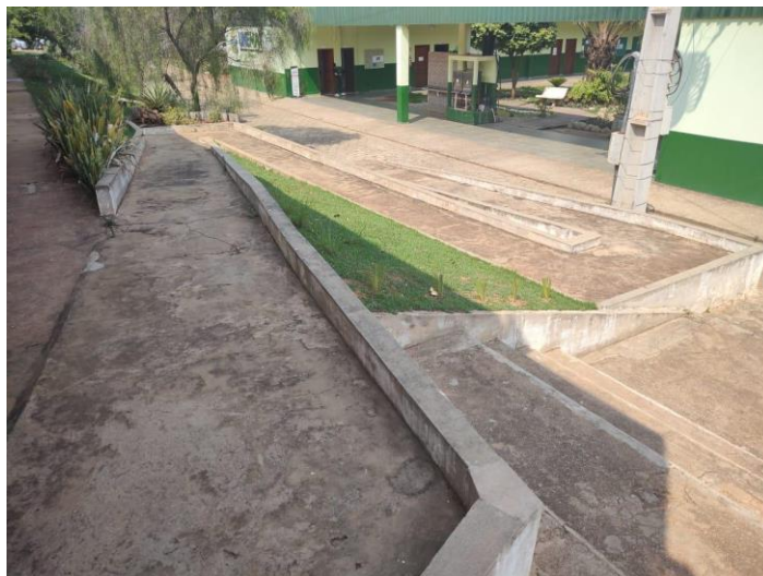
Rampa acessível à Biblioteca, Campus de Alta Floresta
