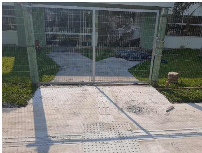
Piso Tátil – Entrada Bloco Q, Campus de Sinop
