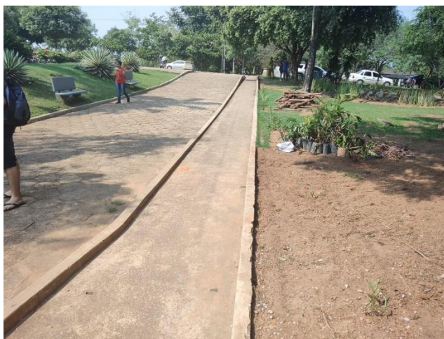
Passarela acessível à Unidade II, Campus de Alta Floresta
