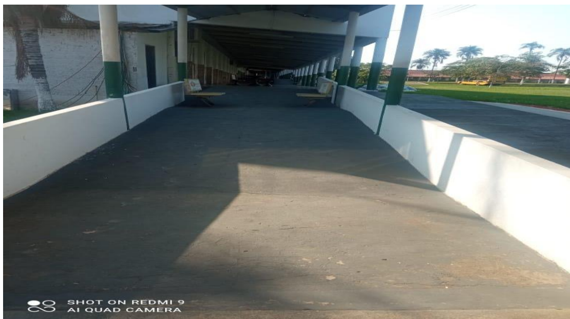
Rampa, acessível CEPAIA, Campus de Alto Araguaia
