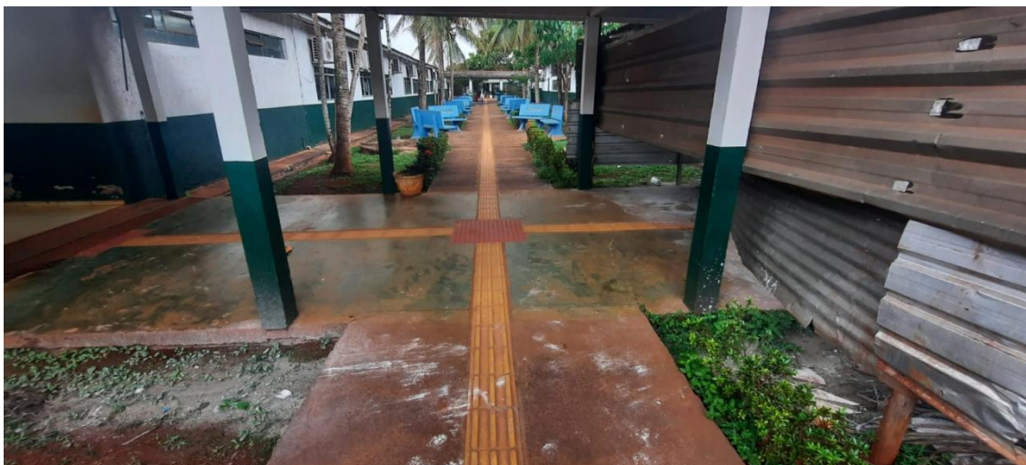
Piso tátil e passarela do corredor, Campus de Tangará da Serra
