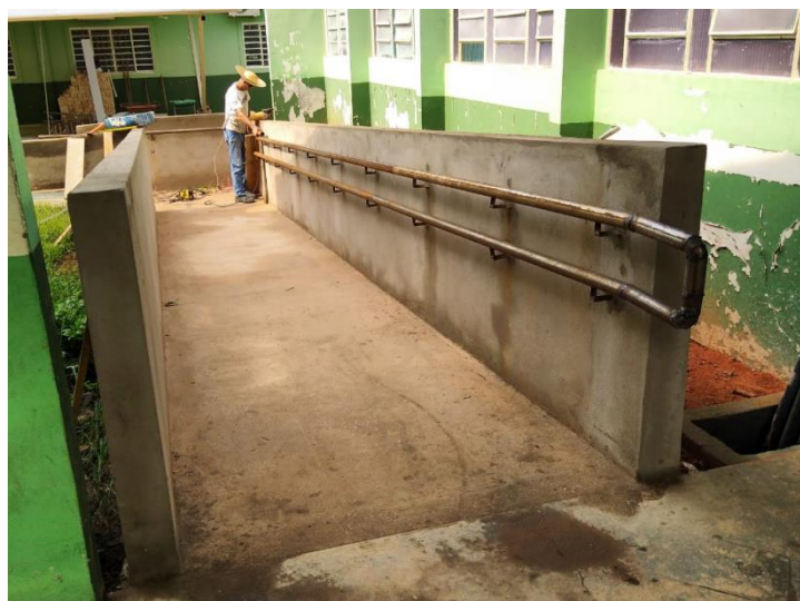
Rampa com corrimão em construção para acesso do Bloco A ao Bloco B, Campus de Barra do Bugres
