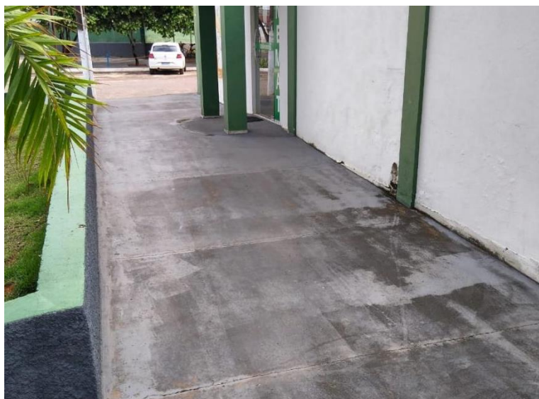
Rampa nivelando toda fachada principal da UNEMAT, Campus de Barra do Bugres
