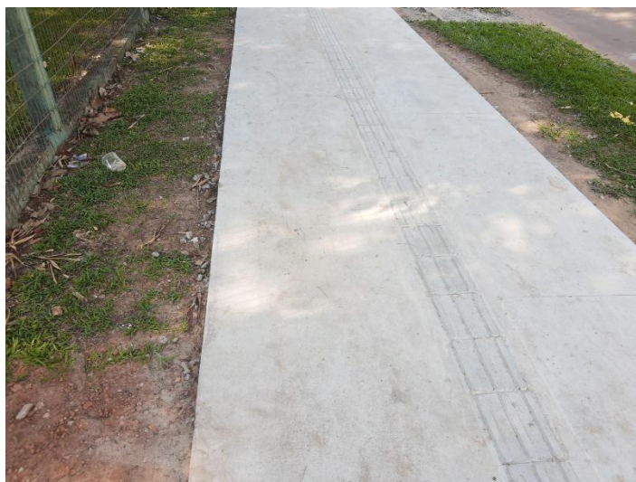
Piso Tátil – Calçada entrada, Campus de Sinop
