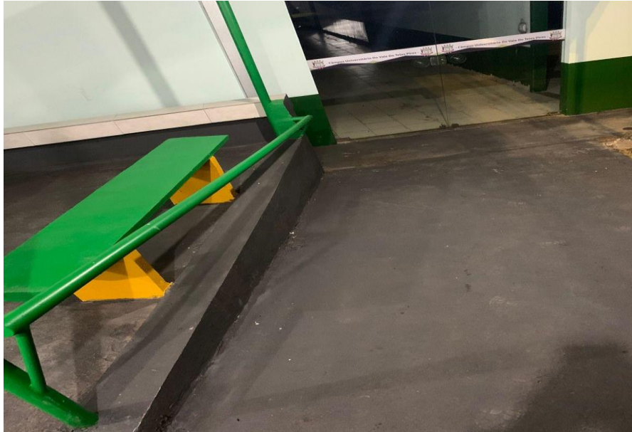
Rampa acessível ao Bloco 2, Campus de Colíder
