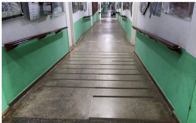
Rampa com corrimão para trânsito no Bloco B, Campus de Barra do Bugres
