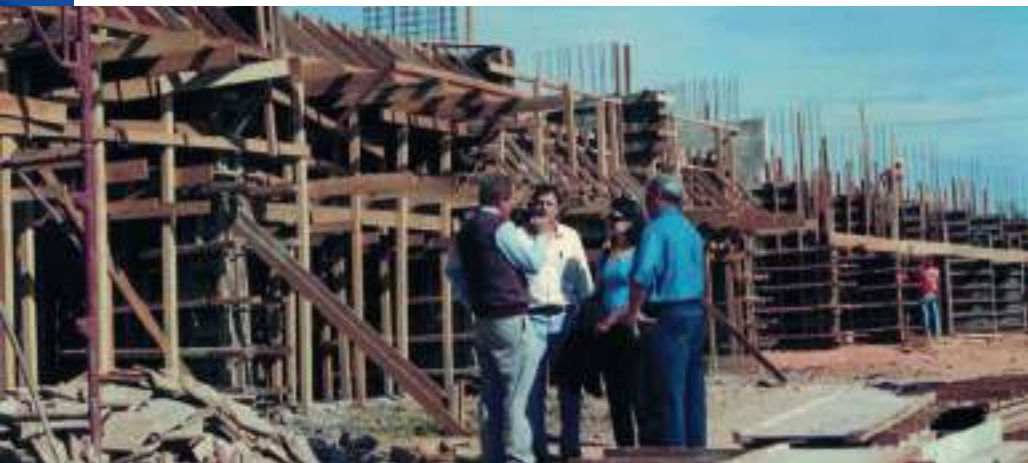
Construção Bloco 2 do Câmpus de Cáceres. Foto: Acervo Unemat.
