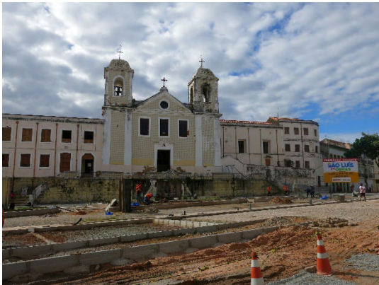
Imagem 5: Reforma da Praça João Lisboa
