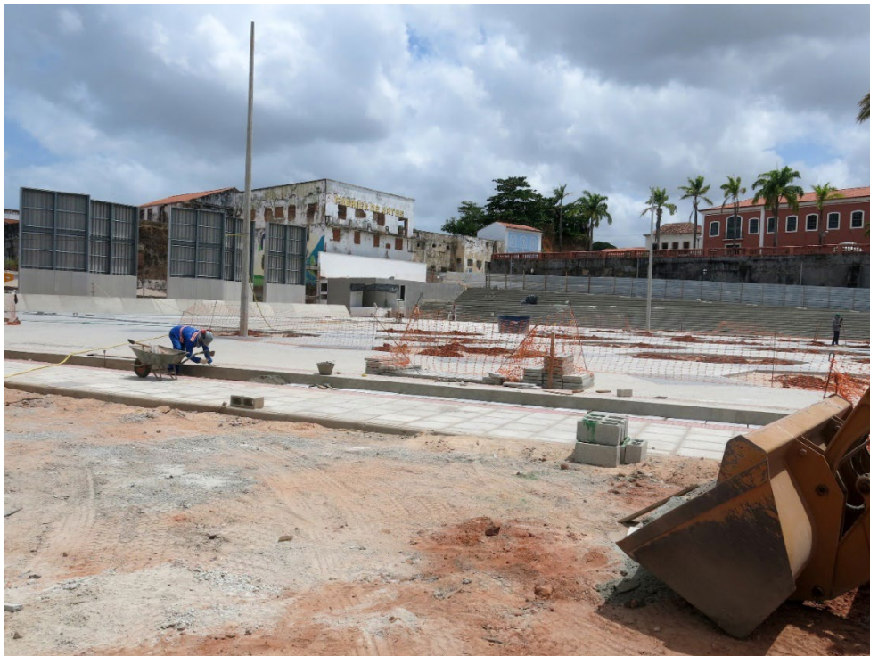
Imagem 9: A obra no espaço onde seria o Memorial da Escravidão
