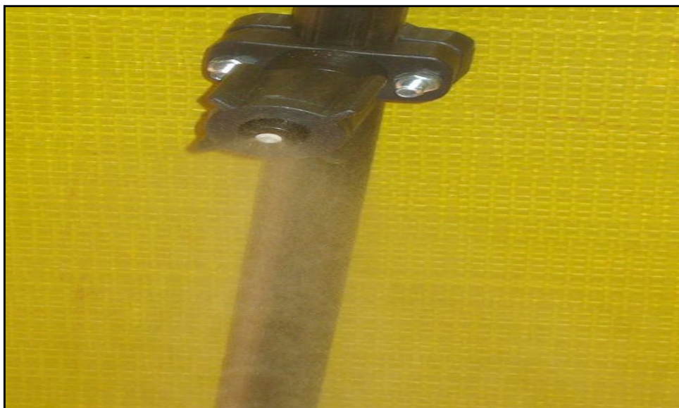
Figura 3: Sistema de nebulização. Fonte: www.avicasp.com.br .
