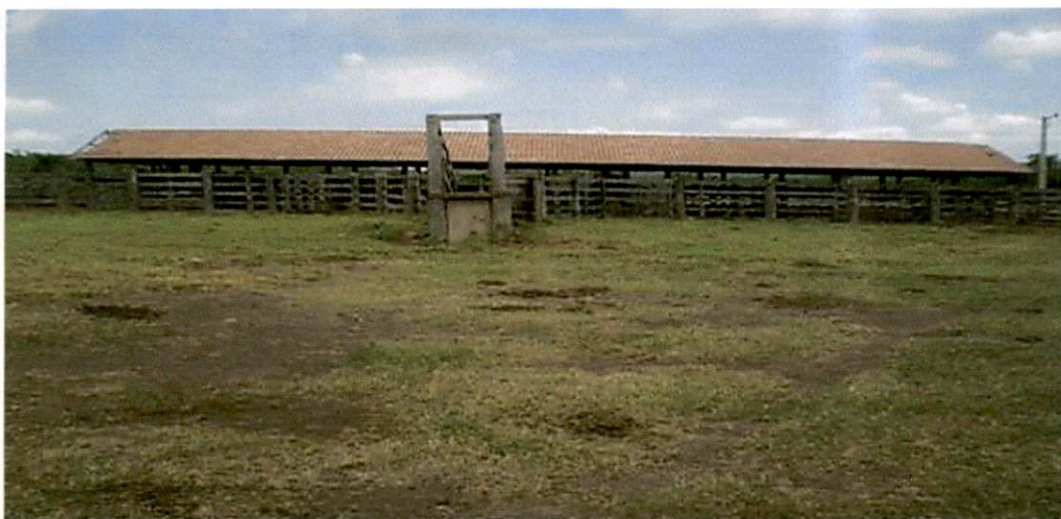
Figura 1. Declividade desejada no terreno onde deve ser instalado o curral, Terreno levemente inclinado.
