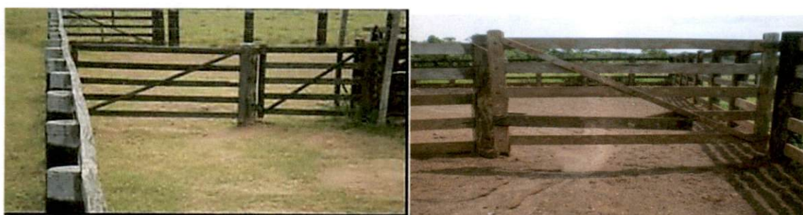
Figuras 2 e 3. Cercas e porteiros em ótimo estado e porteira com régua quebrada com conservação regular.
