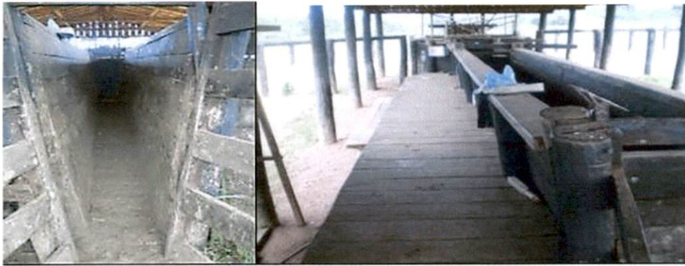
Figuras 10 e 11. Bretes em ótimos estados de conservação.
