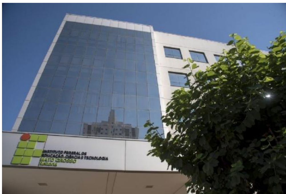
Figura 1. Fachada da Reitoria do IFMT em Cuiabá-MT
