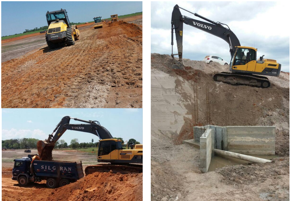
Figura 1 – Etapas da construção e instalação do sistema de drenagem dos 3 tanques escavados, totalizando 27 ha de lâmina d'água, estado de Mato Grosso, Brasil.
