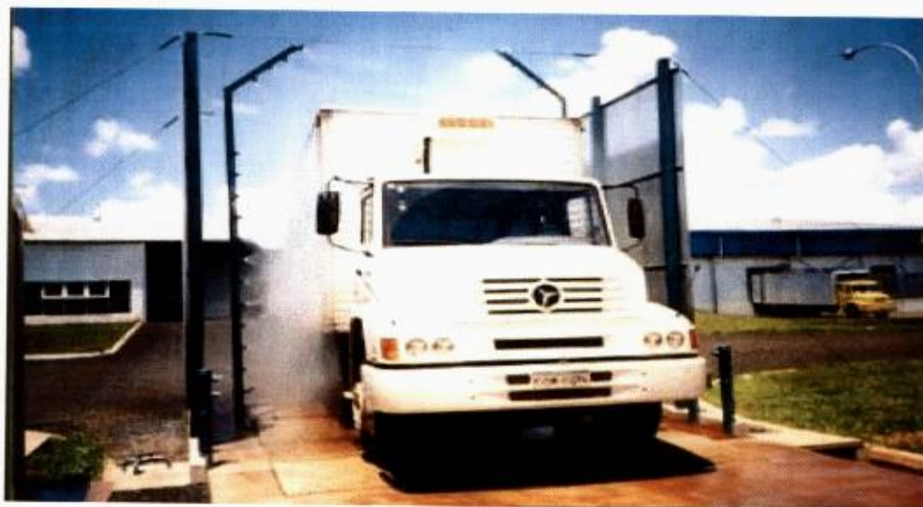
Figura 3: Caminhão passando pelo rodolúvio. Fonte: Atla (2011)
