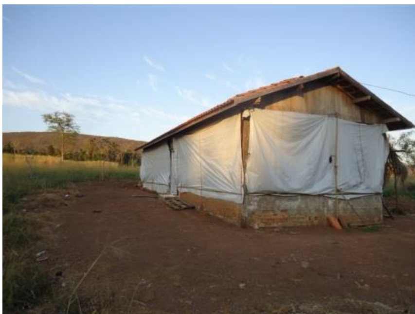
Figura 3: Orientação do aviário no sentido norte-sul.
