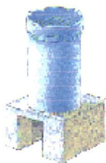
Figura 5. Colocação de suportes na boca da manilha.
