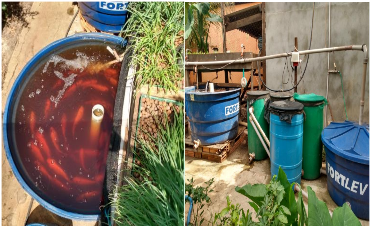
Figura 3 – Abastecimento da água na caixa dos peixes com aeração e movimento circular para melhor transporte da água residual através do overflow para o decantador feita por gravidade no sistema de aquaponia.
