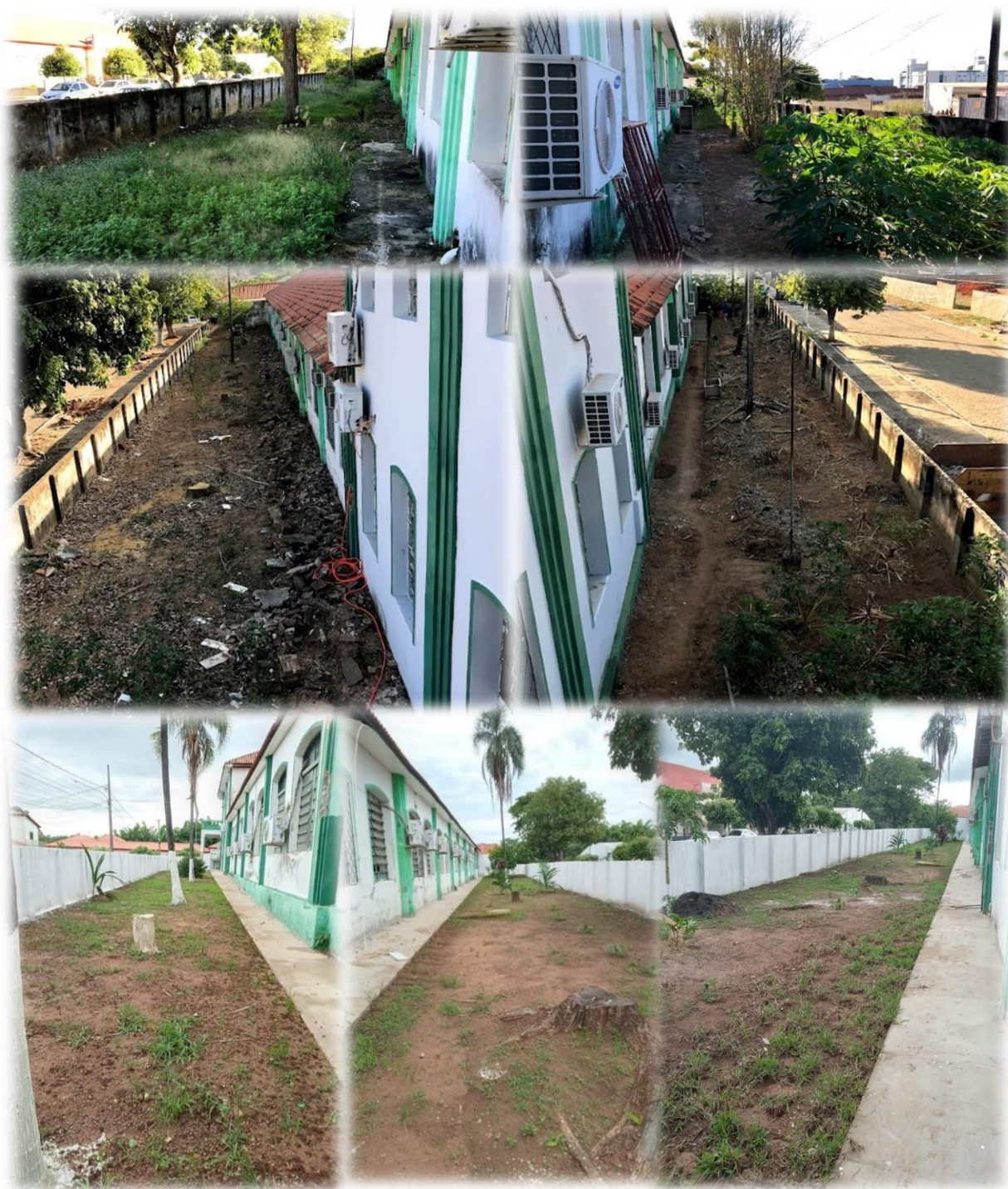
Figura 38 – Revitalização das calçadas internas e jardins laterais do Campus.
