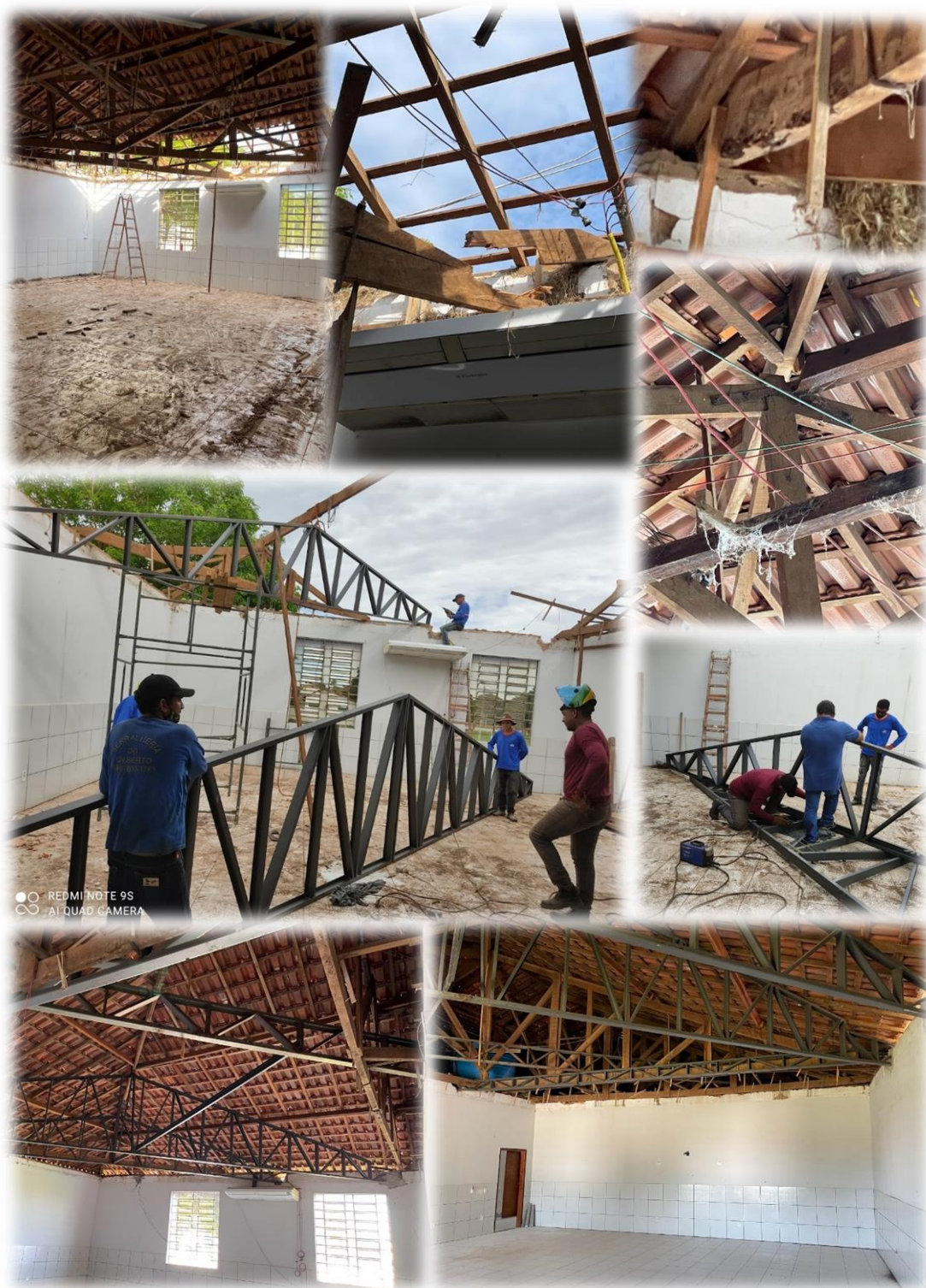
Figura 28 – Reforma do telhado do pavilhão de Letras.
