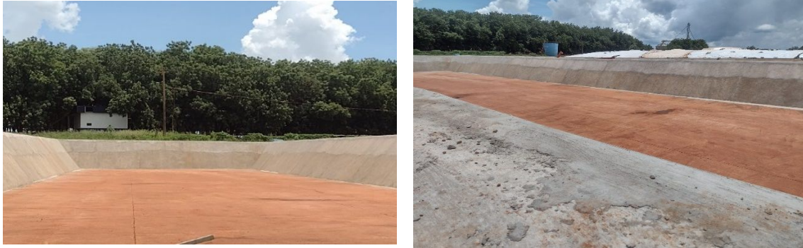
Figura 3 - Imagens de silo trincheira prontos para serem utilizados fonte: https:// Fazendas São Marcelo, Município de Tangará da Serra, MT Silo Trincheira, janeiro de 2023.
