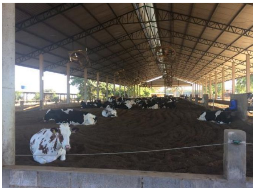
Figura 13. Galpão de compost barn , vacas deitadas e cama recém revirada.
