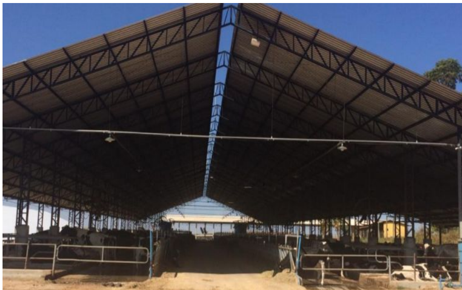
Figura 9. Galpão do sistema Free Stall
