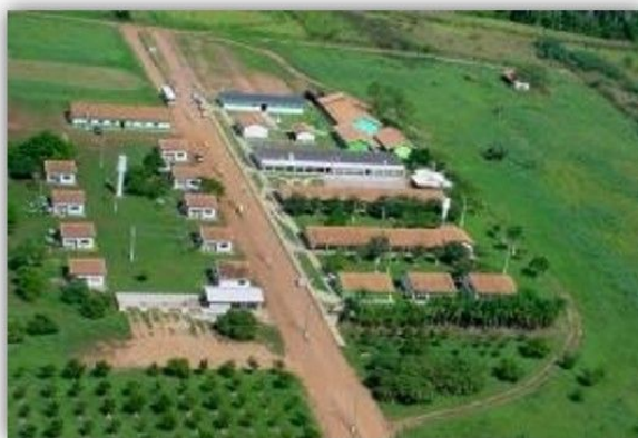
Figura 1: UNEMAT - Campus de Pontes e Lacerda
