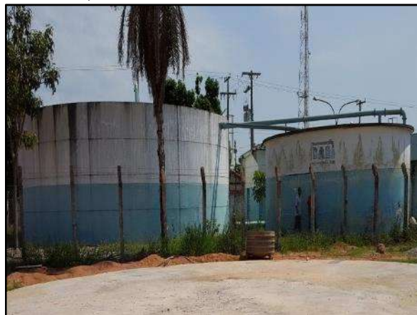
Figura 38. Reservatório RAP-2 e RAP-3 de 1.000,0 m 3 e 500 m 3 no bairro Maracanã
