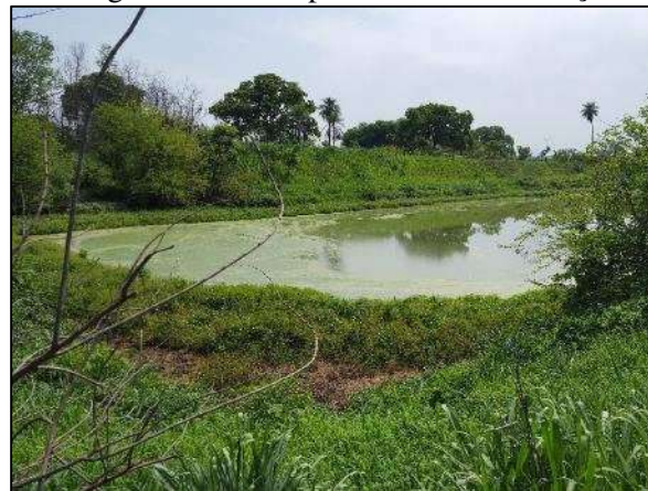
Figura 50. Lagoa de maturação da ETE de Barra do Bugres em estado precário de conservação
