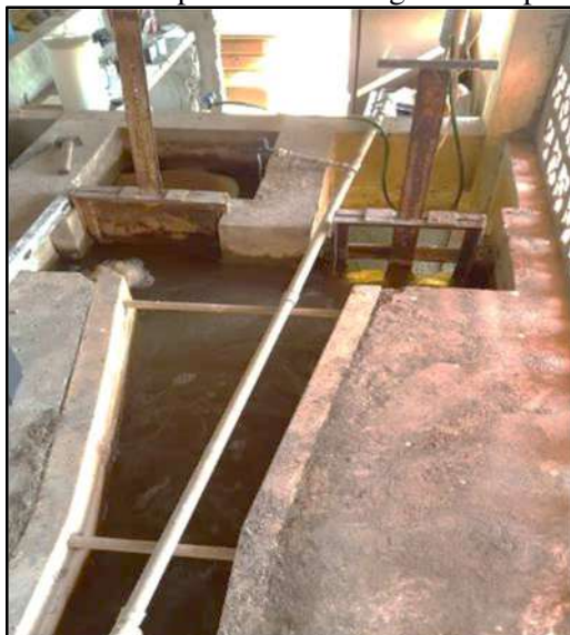
Figura 22. Comportas instaladas a jusante da calha Parshall ocasionando o represamento da água no dispositivo
