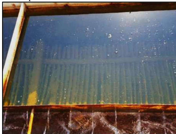
Figura 28. Decantador de alta taxa com placas planas de PVC da ETA metálica
