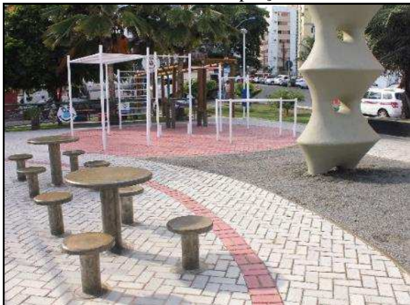
Figura 172. Pavimento poroso – piso intertravado instalado em praça
