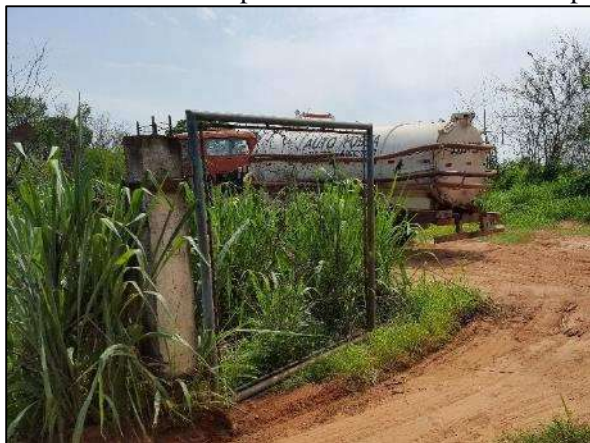
Figura 52. Caminhão limpa-fossa na área da ETE inoperante
