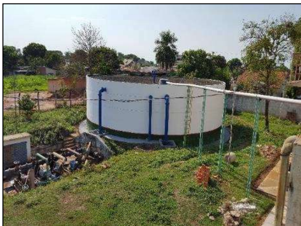
Figura 37. Reservatório RAP-1 de 1000,0 m 3 na área da ETA
