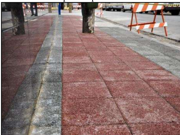
Figura 174. Pavimento poroso instalado em passeio público
