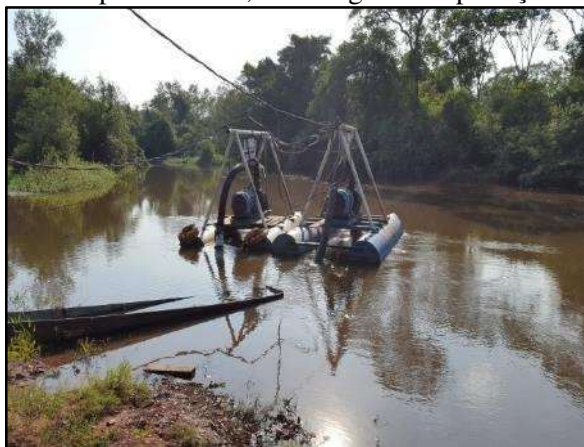
Figura 12. Captação no rio Bugres desprovida de rampa de acesso, balsa e grade de proteção.
