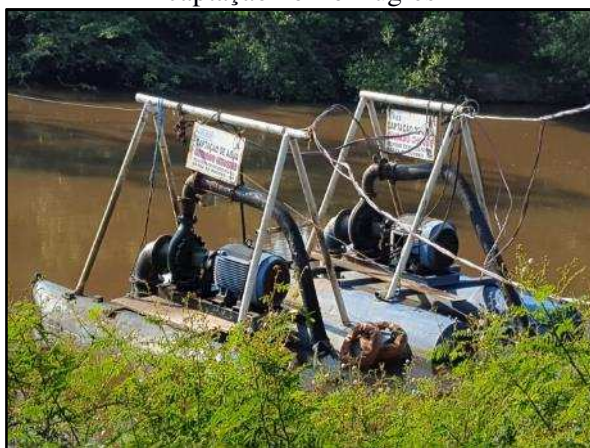
Figura 10. Flutuadores com os conjuntos motobomba de captação no rio Bugres
