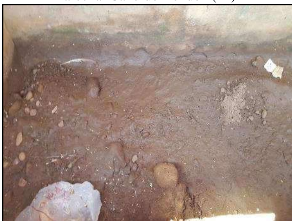
Figura 62. Boca de lobo assoreada na Avenida Marechal Cândido Rondon (12)
