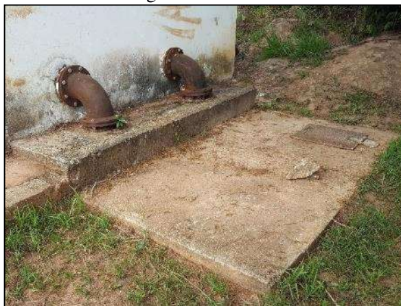
Figura 109. Poço de sucção para tomada indireta da água bruta do rio Bracinho
