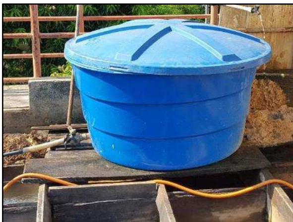
Figura 35. Reservatório para preparo do polímero localizado sobre o floculador da ETA de concreto
