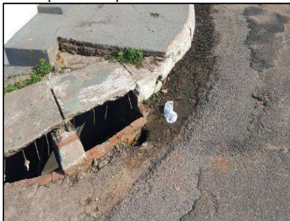
Figura 65. Boca de lobo localizada de forma inadequada na esquina da rua 01 com a rua A
