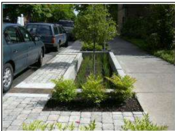
Figura 176. Trincheira de infiltração no passeio
