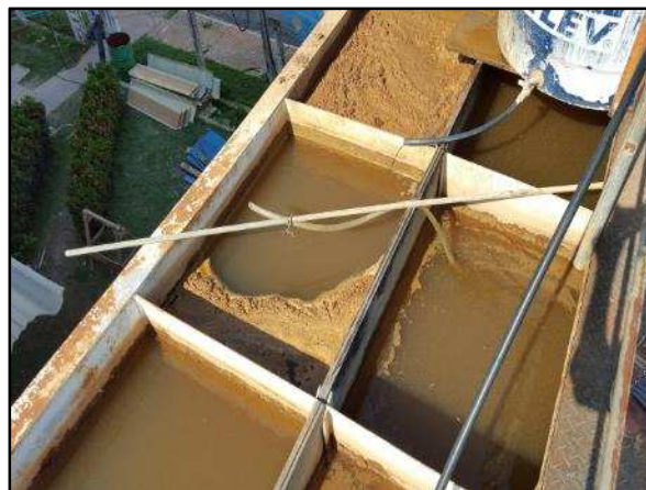
Figura 26. Floculador hidráulico de fluxo vertical com chicanas de madeira da ETA metálica
