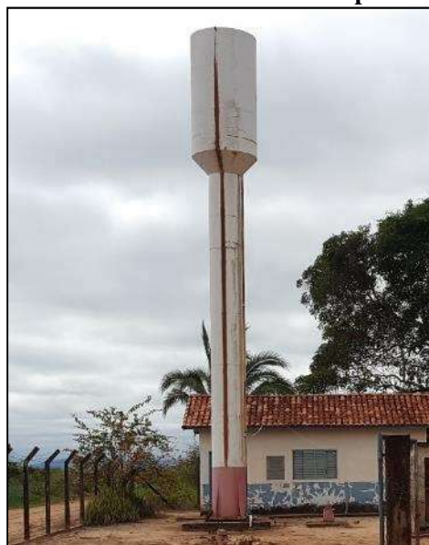
Figura 127. Reservatórios metálicos tipo taça de 12 m³ de Nova Fernandópolis
