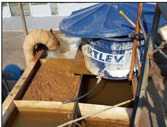
Figura 36. Tanque de preparo da solução de polímero localizado sobre o floculador da ETA metálica
