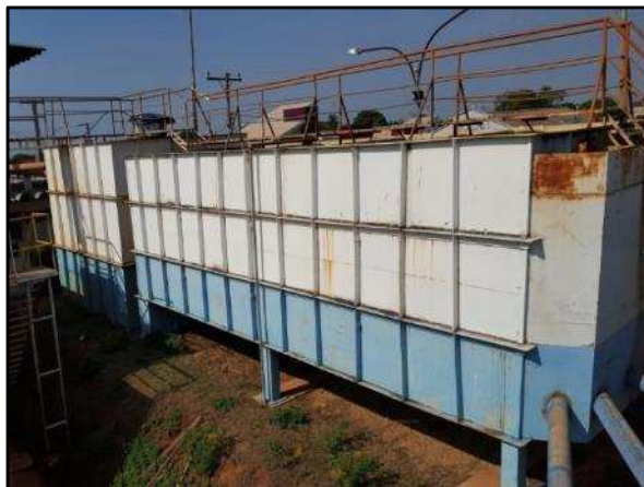
Figura 18. ETA metálica com capacidade para tratar 32 L/s
