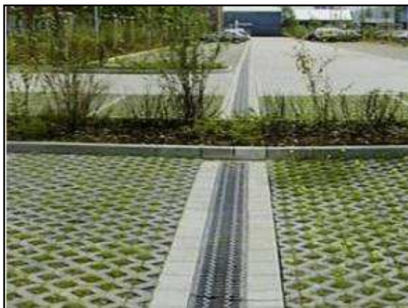
Figura 177. Trincheira de infiltração no estacionamento
