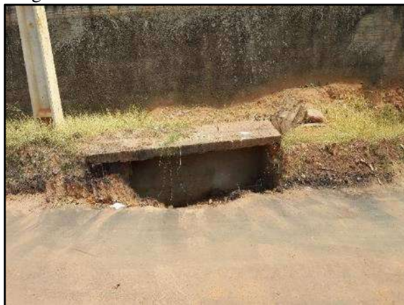
Figura 64. Boca de lobo com engolimento muito grande localizada na rua Alfredo Miranda
