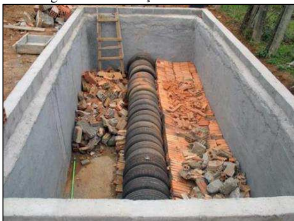
Figura 164. Execução fossa bananeira
