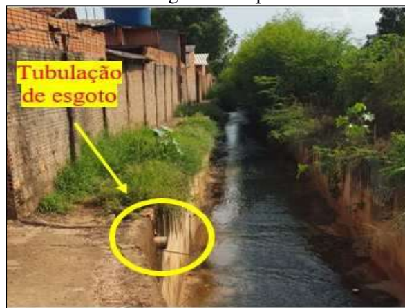
Figura 54. Lançamento de esgoto bruto no córrego do Tanque
