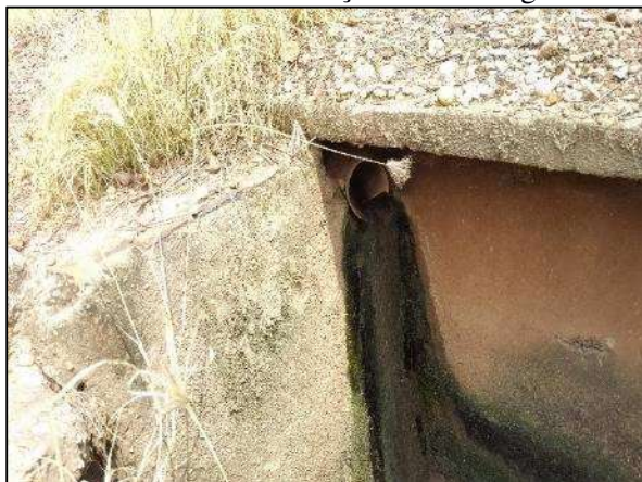
Figura 58. Boca de lobo com lançamento de esgoto clandestino
