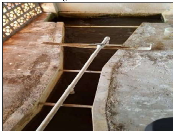
Figura 20. Aplicação da solução de sulfato de alumínio na água bruta na calha Parshall
