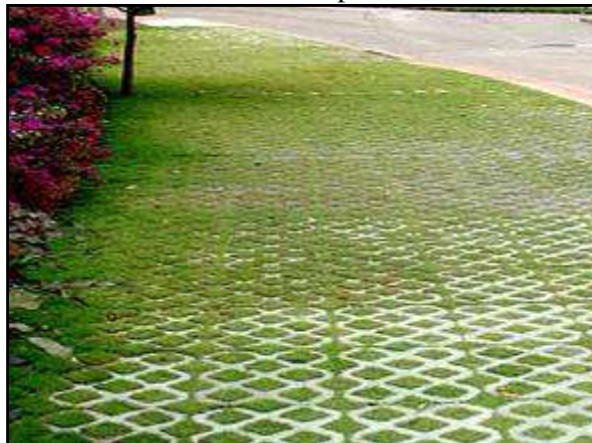
Figura 173. Pavimento poroso – concregrama instalado em passeio
