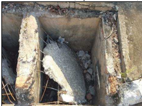
Figura 56. Boca de lobo com tampa danificada na Rua A com a Rua 01 (esquina da UNEMAT)
