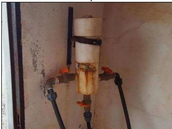
Figura 124. Clorador de contato inoperante em Currupira
