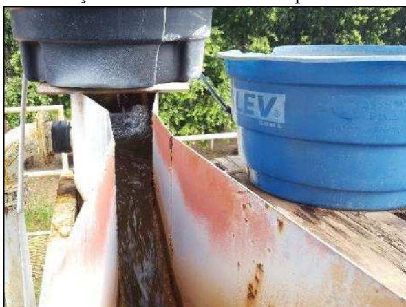
Figura 113. Caixas d'água utilizadas sobre as unidades da ETA utilizadas para o preparo das soluções sulfato de alumínio e polímero
