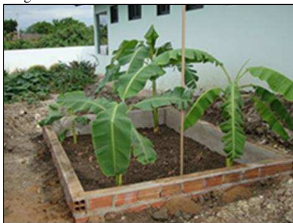
Figura 165. Fossa bananeira em funcionamento
