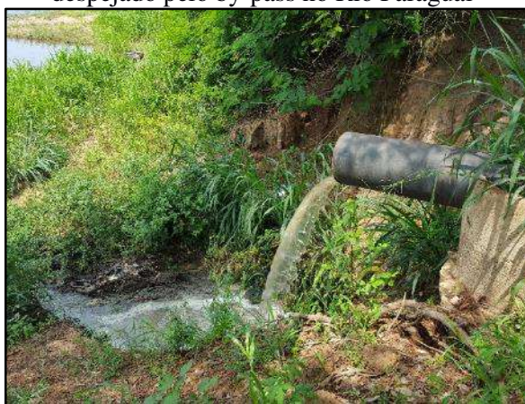
Figura 48. Esgoto sem tratamento na EEE despejado pelo by-pass no Rio Paraguai
