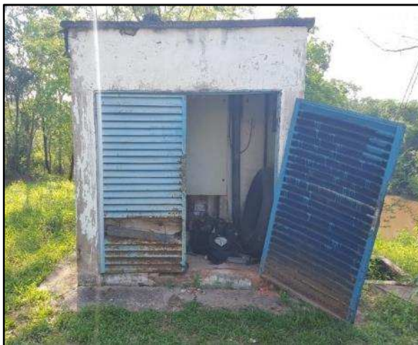
Figura 17. Porta do abrigo do quadro de comando deteriorada
