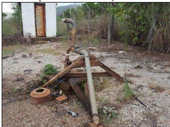
Figura 122. Barrilete do poço de Currupira sustentado por escoras de madeira e fitas de borracha para manter as tubulações conectadas
