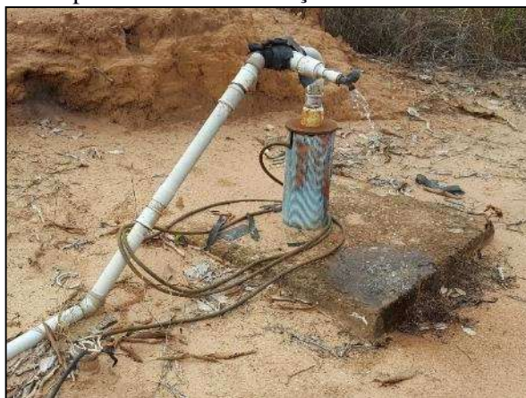
Figura 123. Barrilete do poço de Nova Fernandópolis equipado com fitas de borracha para manter as tubulações conectadas
