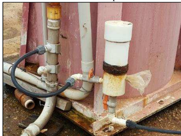
Figura 125. Clorador de contato inoperante em Nova Fernandópolis
