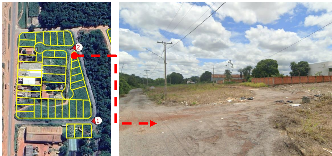
Figura 25 – Ponto 2: Local que deveria ter vielas e rotatórias no bairro Renê Barbour.
