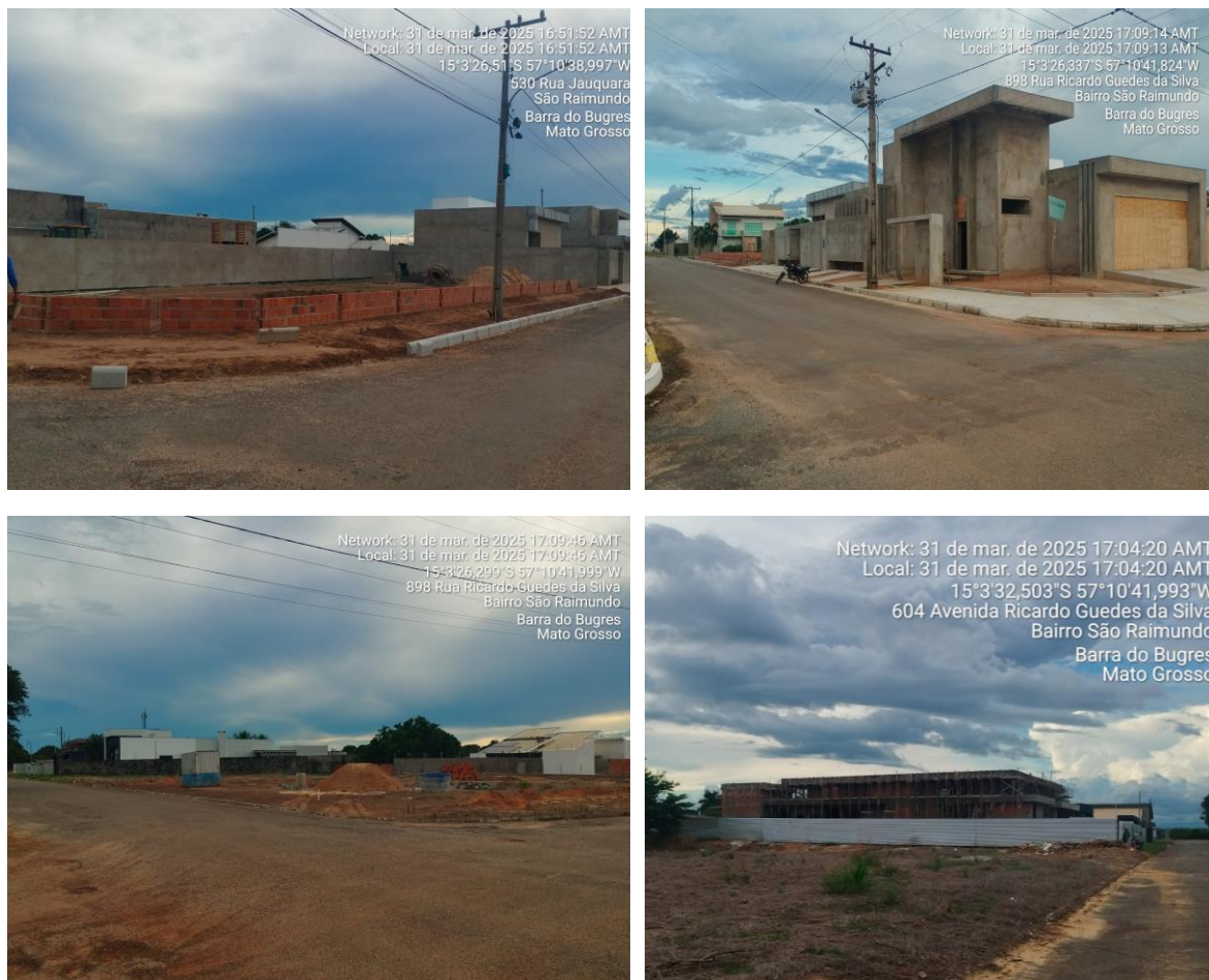
Figura 26 – Terrenos com construções em andamento no bairro Renê Barbour no ano de 2025.
