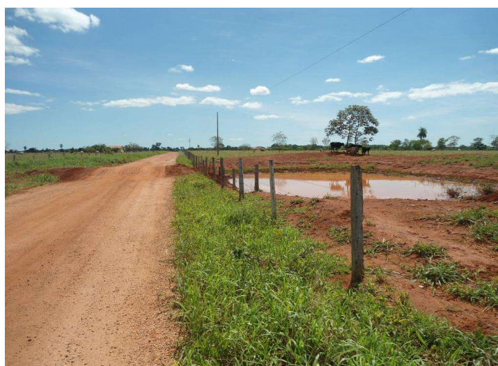
Figura 4 – Barraginha ou minibacia feita do lado da estrada rural para segurar as enxurradas e proteger a estrada e a lavoura. Fonte: Samir Curi.
