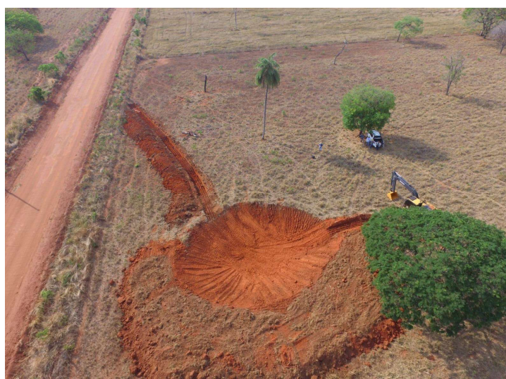
Figura 2 - Detalhe do canal de acesso para a barraginha! Cáceres, 2023. Fonte: Ademir Patrik de Moura
