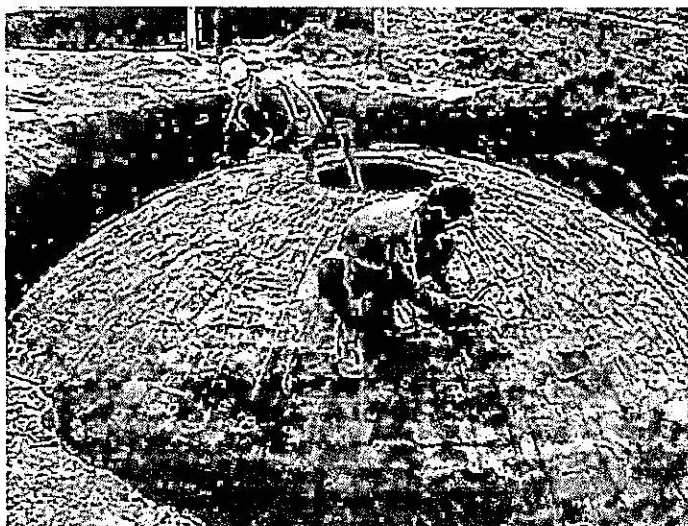
Figura 5. Biodigestor modelo chinês sendo construído sem a técnica de escoramento.
