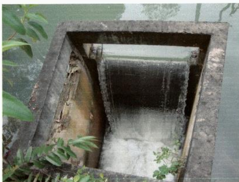
Figura 8: Sistema de escoamento de água tipo monge no município de Figueirópolis D'Oeste - MT.
