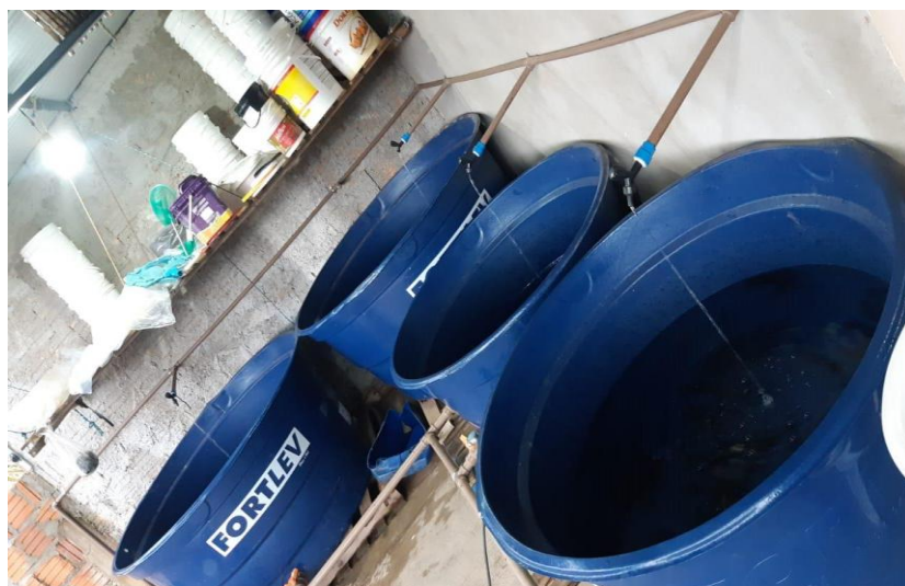
Figura 7. Estrutura das caixas onde são alocadas as iscas quando chegam do transporte com o sistema de encanamento que faz o abastecimento da água e oxigenação.
