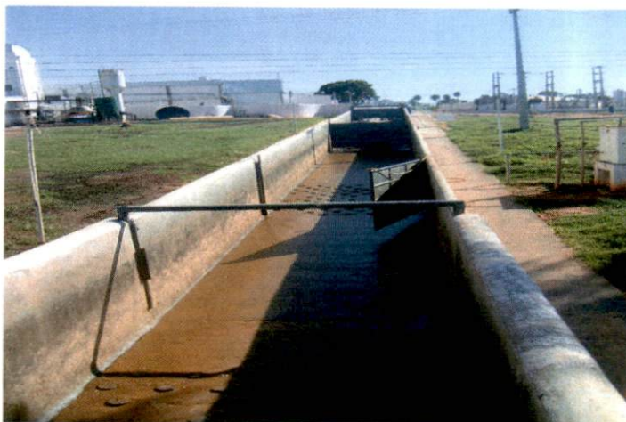
Figura 4: Rampa de acesso ao chuveiro de aspersão
