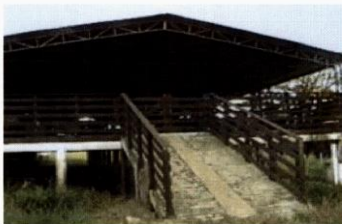
Figura 12: Aprisco de piso suspenso como rampa de acesso. Fonte: Otto de Sá e Sá (2001)
