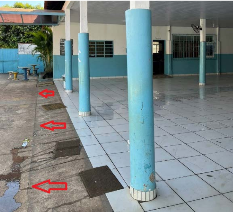
Figura 7 – Rampa de acesso ao refeitório
