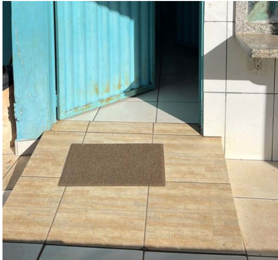
Figura 11 – Rampa da porta de entrada do banheiro sanitário
