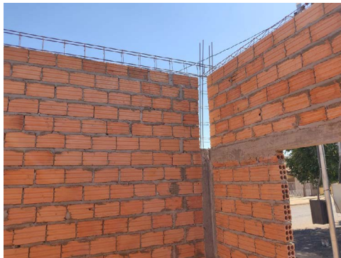
Figura 7 – Armadura presente na viga V7
