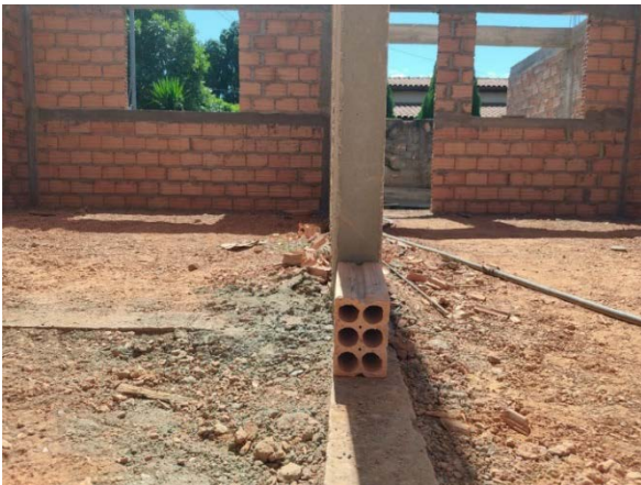
Figura 2 – Tijolo em comparação a viga baldrame
