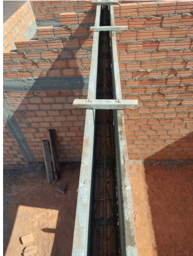
Figura 4 – Forma da viga intermediária com armadura posicionada
