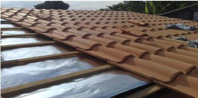
Figura 5 – Telha fibrocimento aplicado o forro de manta térmica
