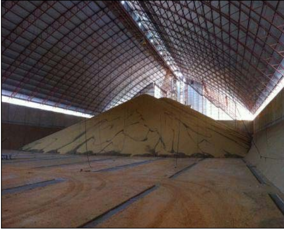
Figura 1B – Armazém graneleiro
