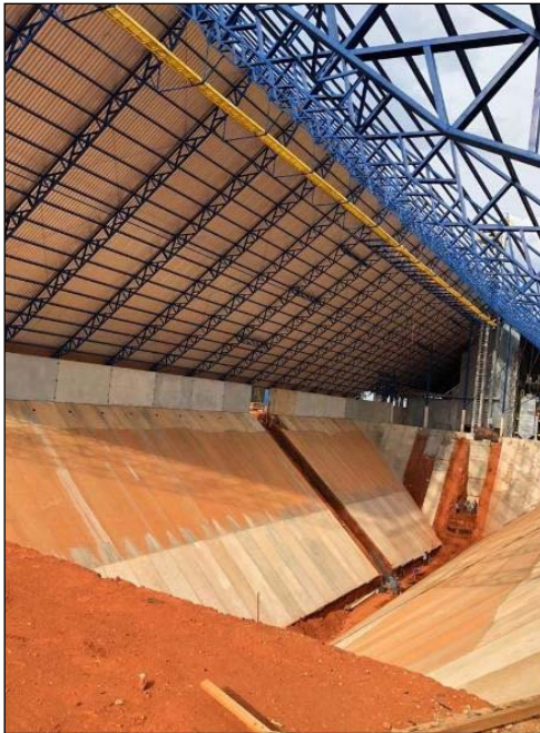
Figura 1A – Armazém graneleiro
