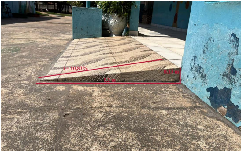
Figura 8 – Rampa de acesso às salas do bloco
