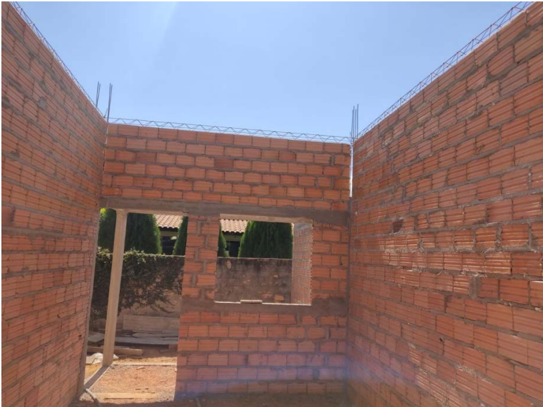
Figura 8 – Armaduras presentes nas vigas V8, V10 e V15
